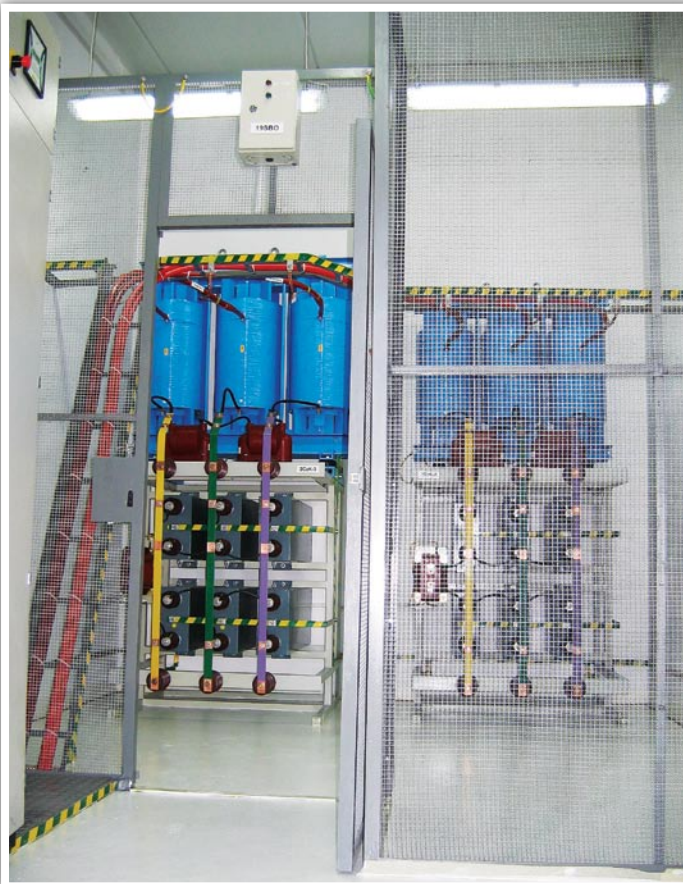
Baterie typu BSWD z polami regulacyjnymi (bateria typu ACRD...z)
