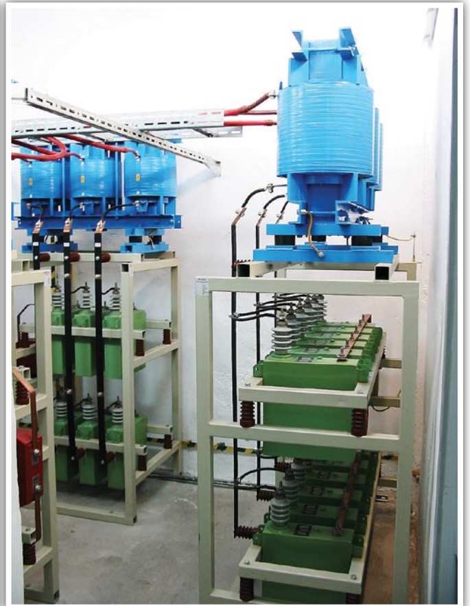
Baterie typu BSWD z polami regulacyjnymi (bateria typu ACRD...z)
