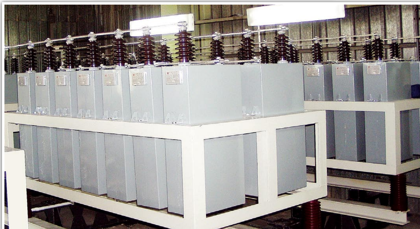
Wnętrzowe baterie średniego napięcia
