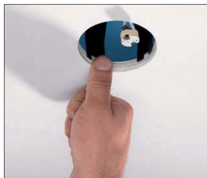
Dociśnij pazurki do płyty gipsowej, żeby zapobiec przesuwaniu się kołpaka.
