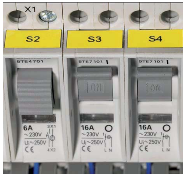
Czytelne etykiety identyfikacyjne ułatwiają zarządzanie siecią przewodów i kabli.
