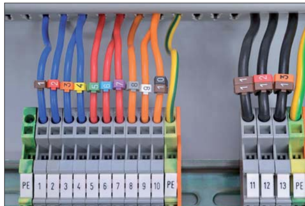
Bezpieczna metoda czytelnego oznaczenia przewodów bez ich rozłączania.
