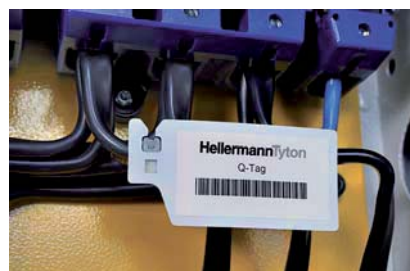
Q-tags mogą być oznaczane przy pomocy wcześniej wydrukowanych etykiet lub opisywane ręcznie.
